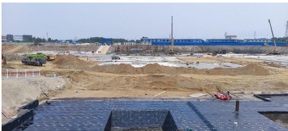
图 2-5 地块施工现场
